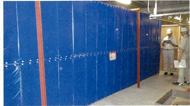
保管場所 地下1階 ベニヤ板仕切り内側の保管施設 鉛シート（青色部分）を貼り付けた囲い壁
