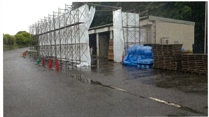
旧保管施設全景
