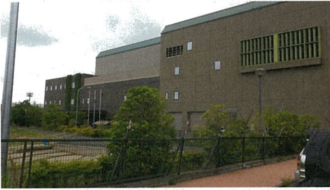
保管場所建屋外観
