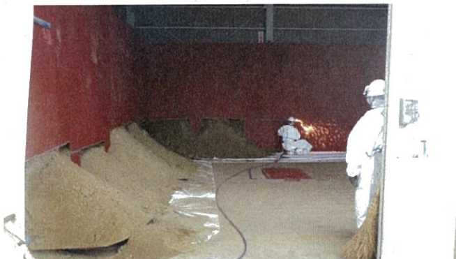
旧保管施設内部解体中 （遮蔽用砂箱解体）
