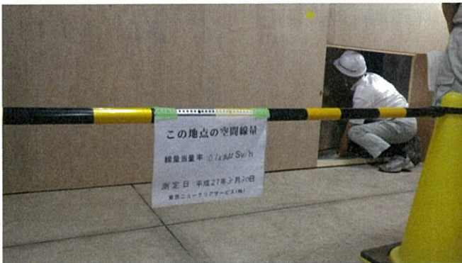
保管場所 地下1階 ベニヤ板仕切り入口 コーン及びポールで立入禁止エリア設置
