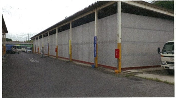
保管場所全景 収集車の駐車場を利用しボックスカルバートを設置
