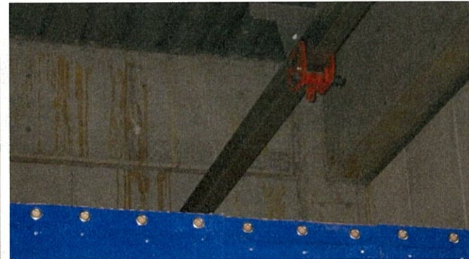
保管場所 地下2階 天井部分
