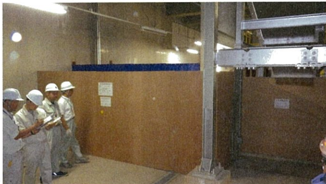
保管場所 地下2階外観 外側ベニヤ板仕切り、内側に鉛シート（青色部分）を貼り付け
