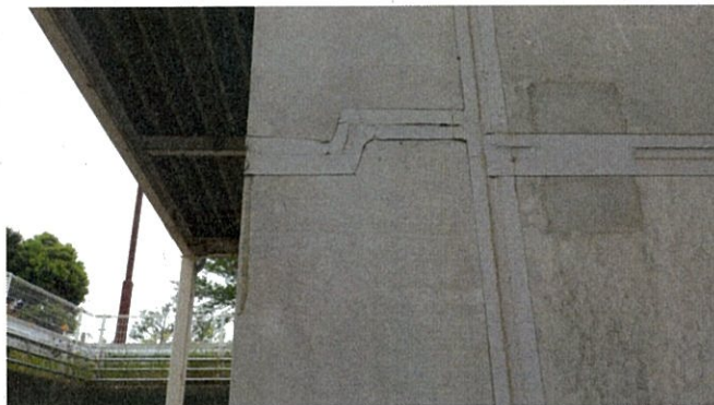
保管状況 ボックスカルバートの連結部
