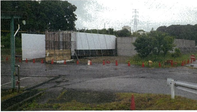
ボックスカルバート全景（入口） 前面テントは搬入するための仮設
