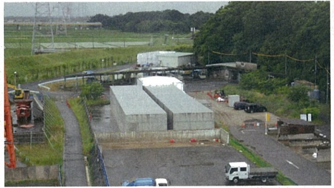
ボックスカルバート全景（2棟）
