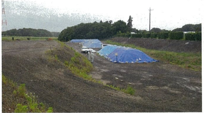
保管状況全景 最終処分場内に4ブロック保管
