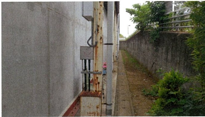
保管場所裏側 右側土手上 敷地境界
