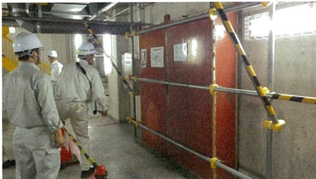
保管場所 地下2階外観 砂を詰めた鉄製壁で遮蔽
