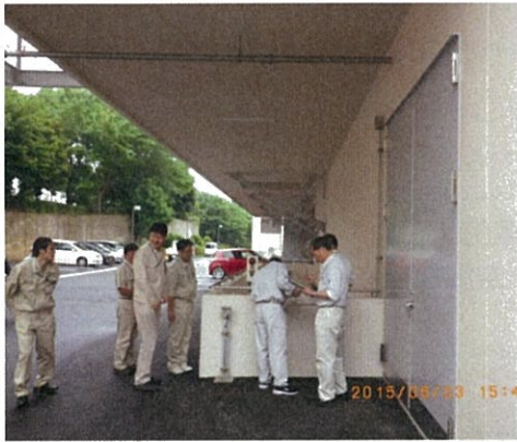
ドライエリア地上部 腰壁部分
