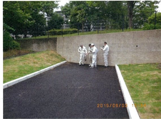
敷地内外周道路北東側
