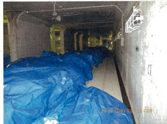
主管廊エリア 保管状況
