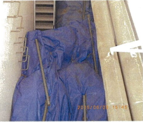
ドライエリア内地下部分の指定廃棄物保管状況
