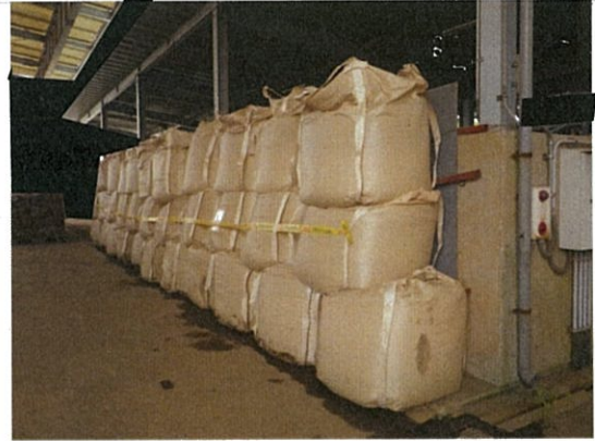
保管状況 鉄板及び山砂入り土のう3段積みで遮蔽
