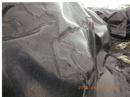
遮水シートの接着状況
