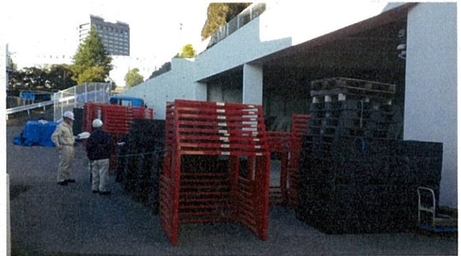
保管場所全景の右側。 積み重ねたパレット等で囲いをし離隔の距離を保っている。
