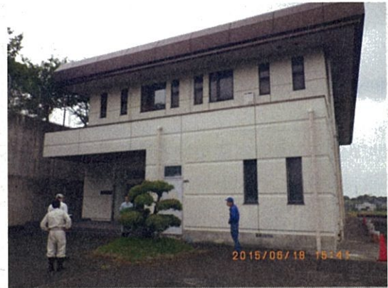
中継ポンプ場外観 1階右側保管場所（つげの木後方入口）
