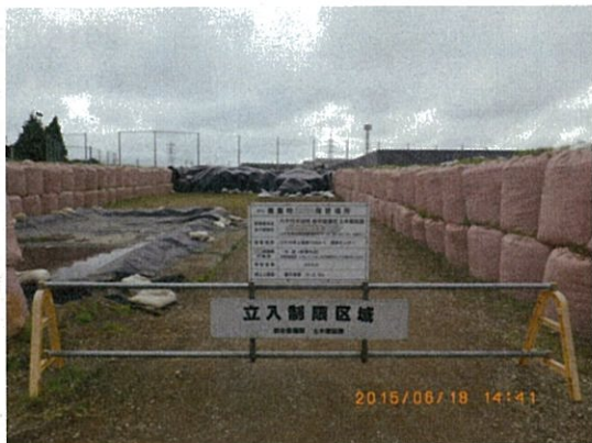
保管場所全景 左右は遮へい用土のう 奥が指定廃棄物
