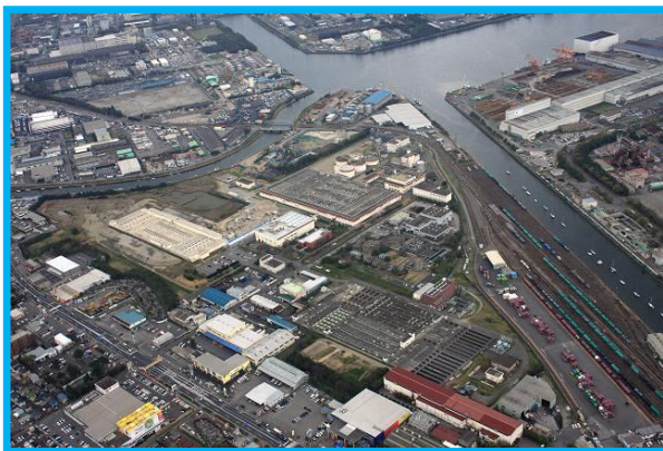
南部浄化センター
