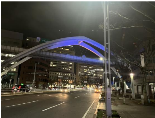
千葉駅側から撮影（青）
