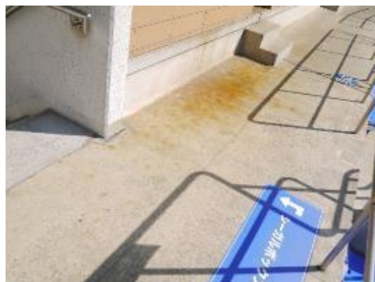
【写真②：通路の錆水による変色】
