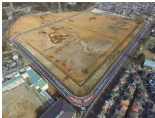
造成工事完了後のネクストコア千葉誉田
