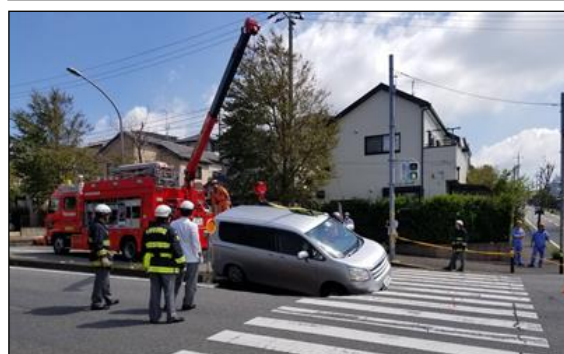
令和元年9月17日緑区あすみが丘道路陥没事故
