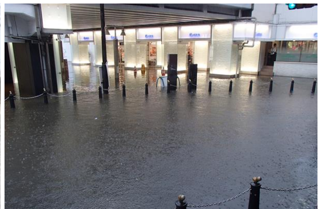
JR千葉駅前の浸水状況
