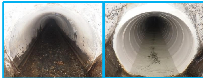
管きよの改築
