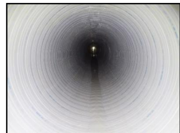
改築後 (管更生)
