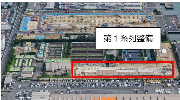
中央浄化センター
