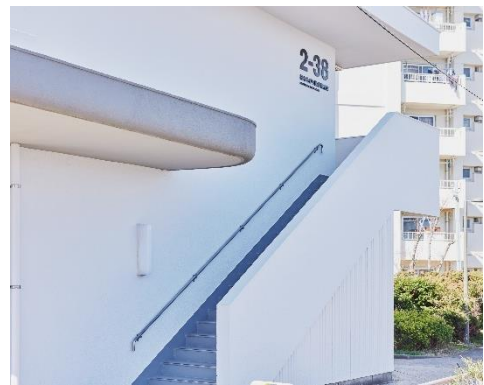
商店街施設棟の外壁
