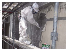
新環境配慮型剥離剤ケレン工法
