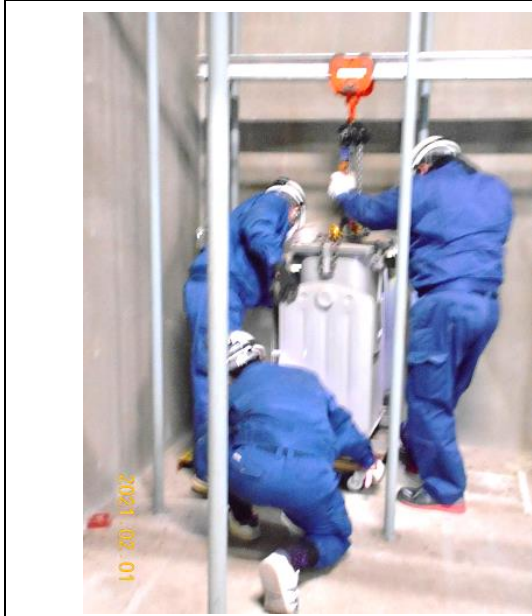
● 変電室からの撤去作業開始。
