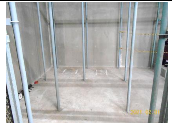
● 変電室内からの撤去作業完了。
