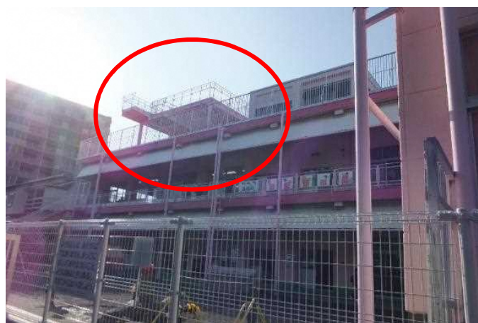
図 15 屋上への避難場所を増築した事例
