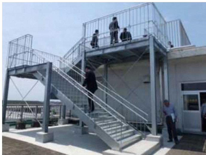
図 14 避難階段および屋上フェンスの設置事例
