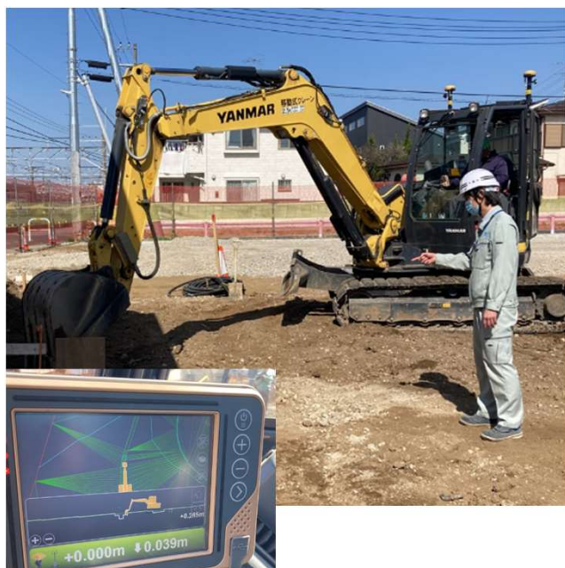
駅前広場工事
