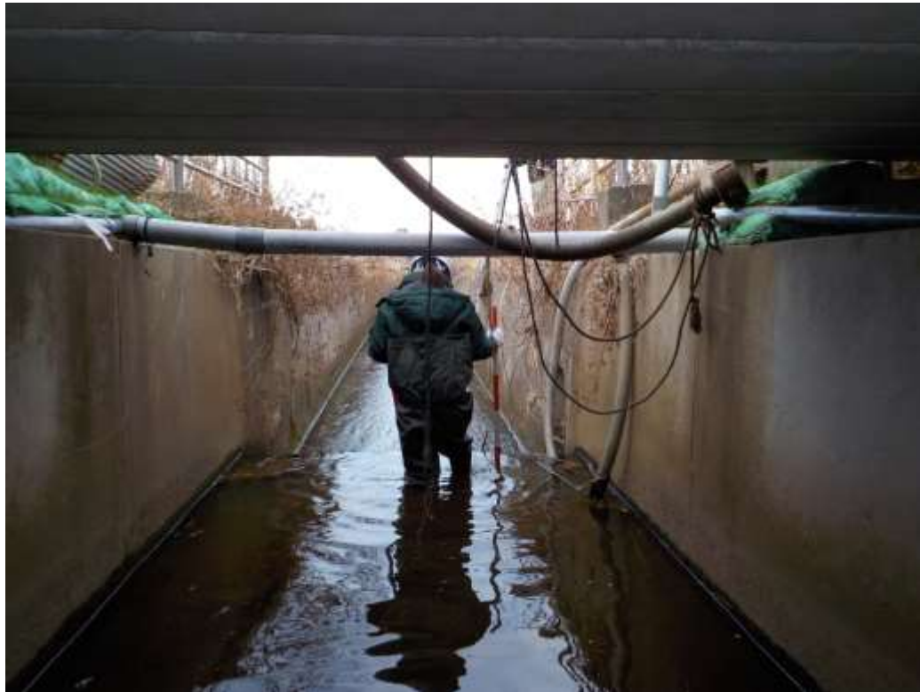
職員橋梁点検の様子
