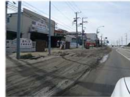
幹線道路に多量の土砂流出 周辺工業地帯の施設に被害多
