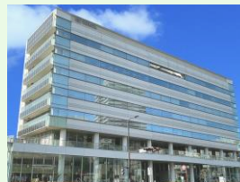
建物外壁への導入
