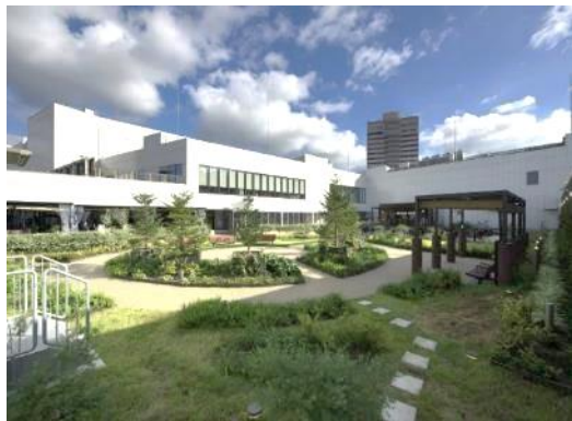
屋上緑化（JR千葉駅）
