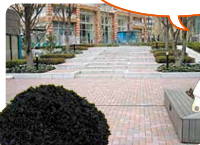
↑ スラグで作ったブロックをしいた歩道 ↑ 灰からできたスラグ
