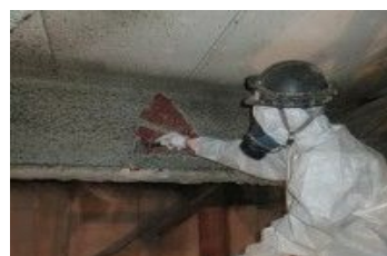
③-3 アスベスト除去状況例
