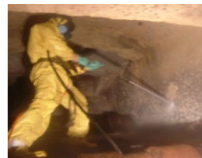
④-1 高圧洗浄状況例
