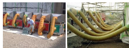
③-1 負圧除塵装置設置例
