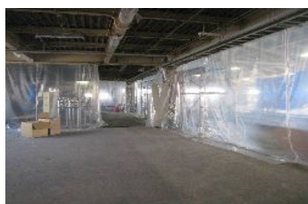
②-1 隔離養生施工例
