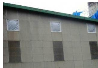
②-3 建屋開口部密閉状況例
