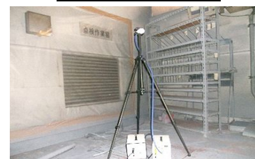
⑦-2 空気中環境測定状況例
