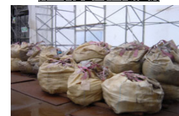
⑥-1 一時保管状況例
