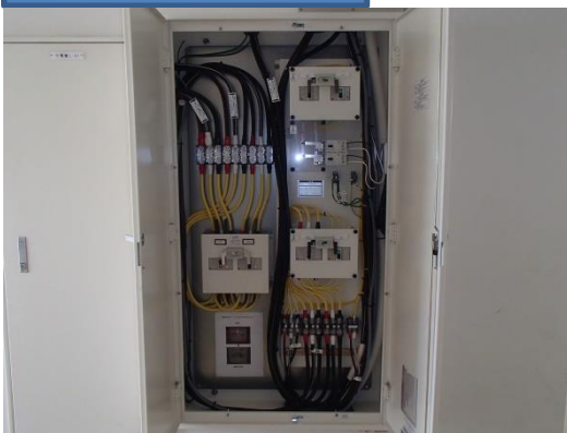
電源切替開閉器盤内部
