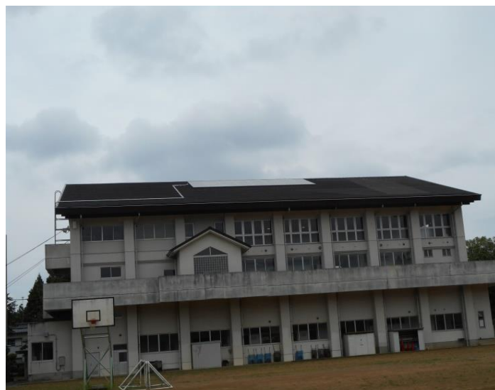
太陽光パネル(10kW) 京セラ製 体育館屋上
