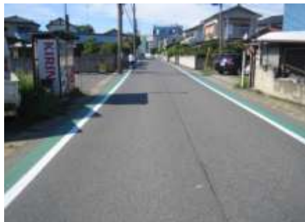
路肩のカラー舗装整備事例
