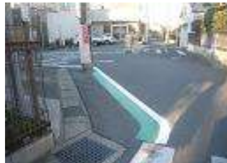
路肩のカラー舗装化で歩行者溜まりを確保した事例
