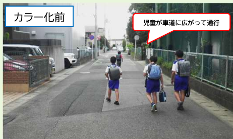
路肩のカラー化前の状況
