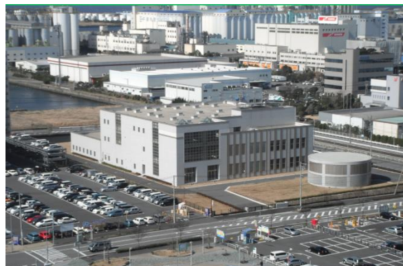
中央雨水ポンプ場
