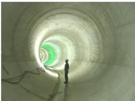
中央雨水 1 号貯留幹線
