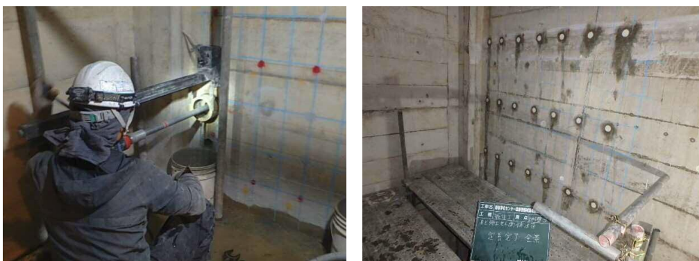
耐震補強工事（補強筋施工）
