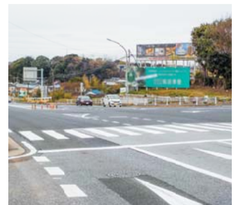
市内の路面標示の様子
