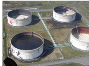
【浮き屋根式タンク】
