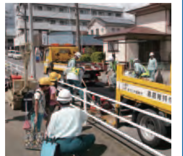
道路補修作業の様子
