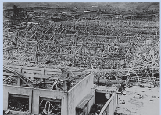
三菱兵器製作所大橋工場(小川虎彦氏撮影) 工場は鉄骨に鉄板を張って作られていましたが、爆風で鉄板は粉々に飛び散り、鉄骨は折れ曲がり、工場は倒れました。 (長崎原爆資料館提供)
