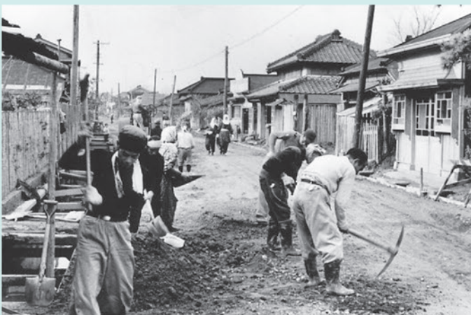
勤労奉仕 昭和22年(1947年)頃、浜野町付近。近隣の人々が協力しあい、道路工事をを行いました。
