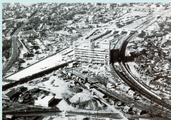
移転工事中の国鉄千葉駅
