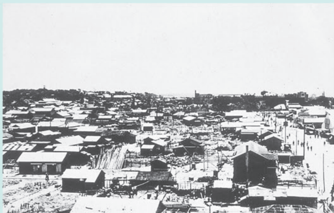
吾妻町付近(現在の中央区中央) 千葉銀行本店屋上から見た亥鼻山・県庁方面。(昭和21年〔1946年〕8月)
