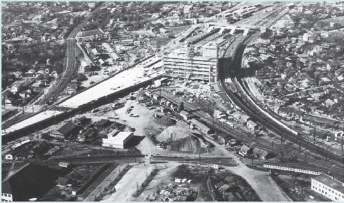
移転工事中の国鉄千葉駅 昭和38年(1963年)4月28日に開業しました。
