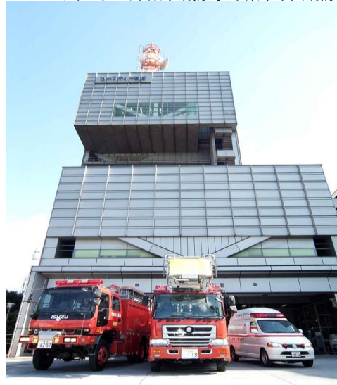
■セーフティーちば(千葉市消防局・千葉市中央消防署合同庁舎)
