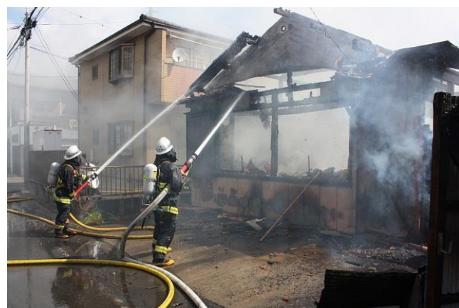
■住宅火災(平成22年9月・千葉市)
