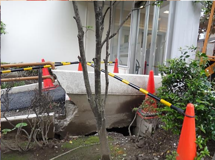
↑エントランスが崩壊したマンション
