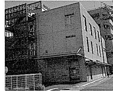
No. 4 救急棟増築外工事
