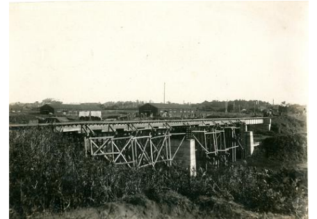
綿打池付近での架橋訓練の様子
