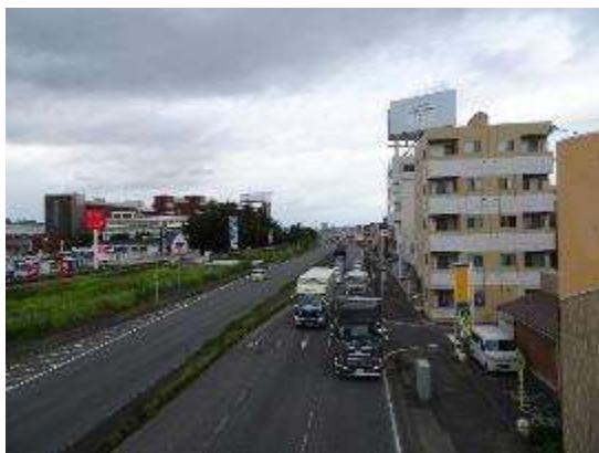
国道357号(蘇我副都心付近)
