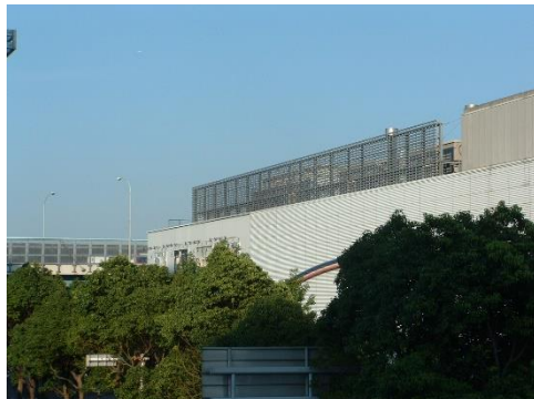
屋上設備を遮蔽し目立たせないよう工夫している。
