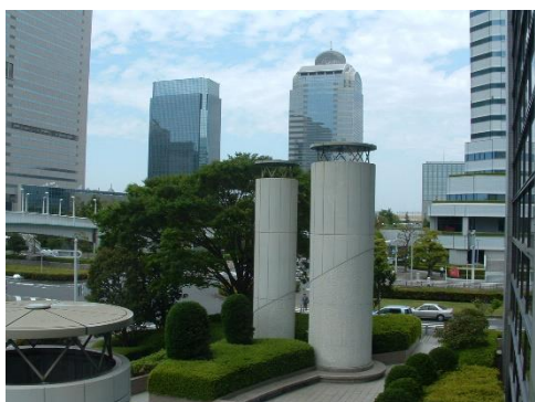
排気筒を周辺に溶け込ませるようデザインに配慮している。
