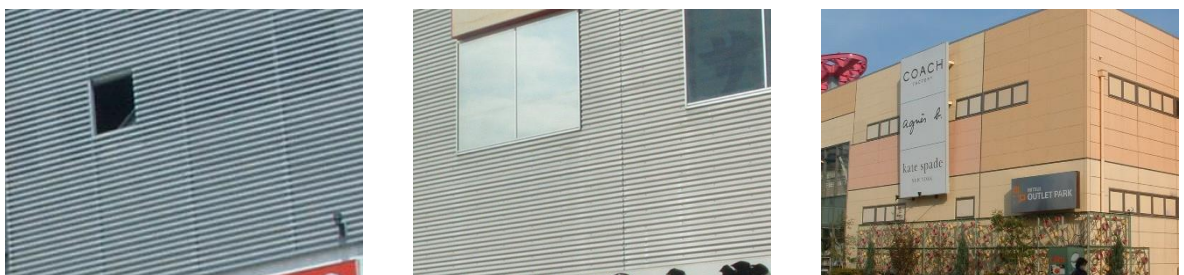
タウンセンター地区における外壁の色彩・材料の例
