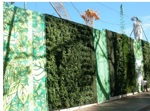
工事中の仮囲いの一部に壁面緑化を取り入れ、うるおいを創出している。
