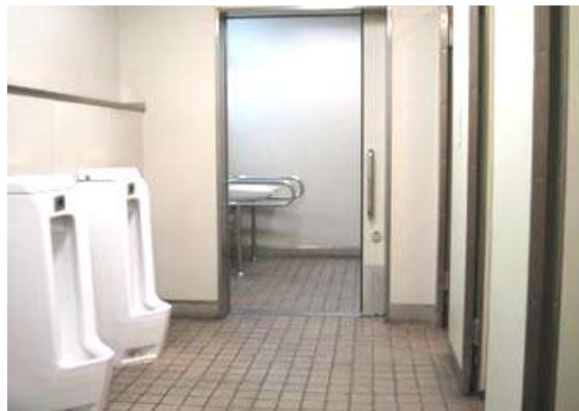
(車いす使用者用トイレの設置)
