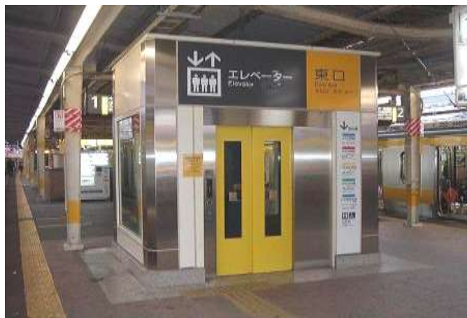
(駅舎内のエレベーター設置)
