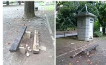
③公園のベンチ破損 解決前
