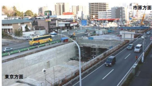
(登戸交差点付近の地下立体部)
