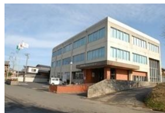
(H25耐震改修工事を実施予定 畑コミュニティセンター)
