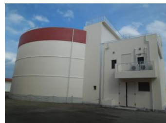
(汚泥消化タンク全景)
