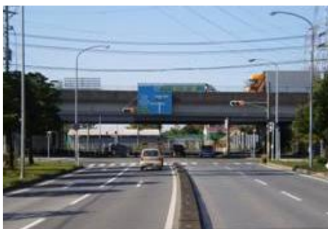
(国道16号付近供用区間)
