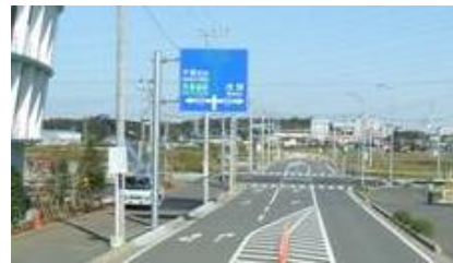
(古市場町一部供用区間)
