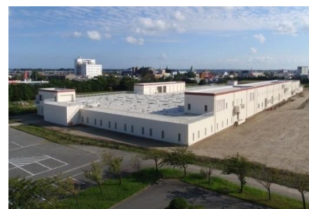
(高度処理施設全景)
