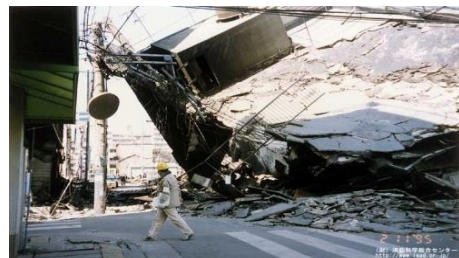
（阪神・淡路大震災被害による道路閉塞の様子）
