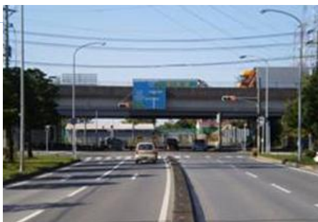
(国道16号付近供用区間)
