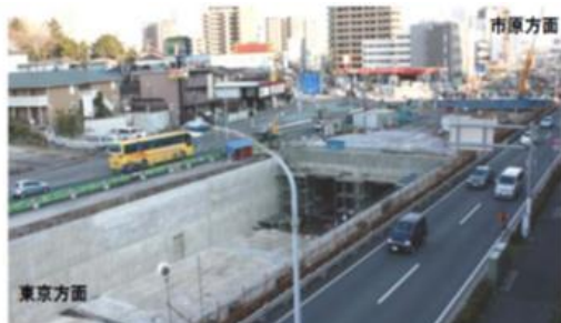
(登戸交差点付近の地下立体部)
