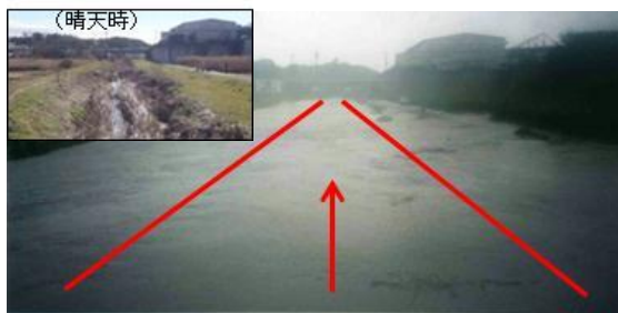
(坂月川の浸水被害の様子)
