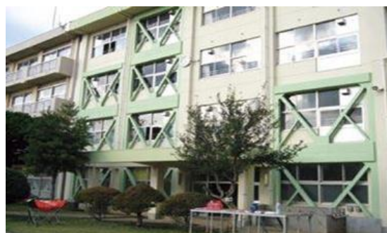
（校舎耐震補強後のイメージ）
