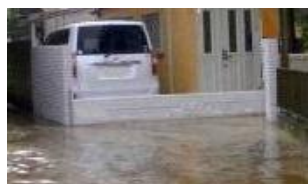
（防水板設置例）
