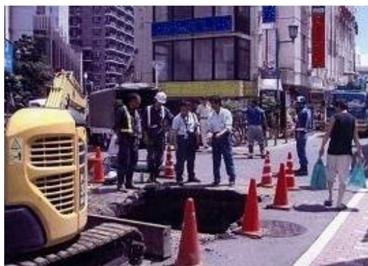
(市街地での道路陥没)
