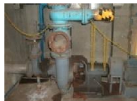
(老朽化したポンプ)
