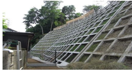
(園生町施工後)
