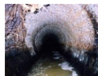
更新前の 管渠内部状況
