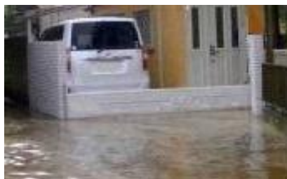
(防水板設置例)
