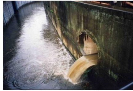
(雨天時の未処理下水流出状況：葭川)
