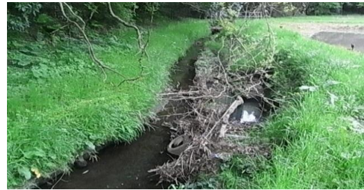
(高田排水路東部支線)
