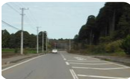
一部供用区間(若葉区中田町)
