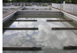
(最初沈殿池・污泥掻寄機)
