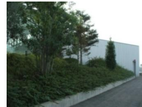
(千葉市生涯学習センター屋上の緑化)
