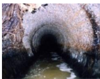
更新前の 管渠内部状況
