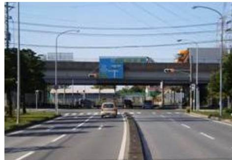
国道16号付近供用区間
