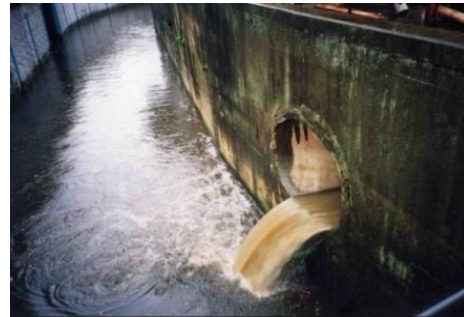
(雨天時の未処理下水流出状況：葭川)
