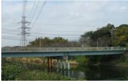
亥鼻橋(現況)河口から約6km
