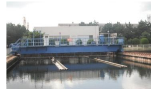
(最終沈殿池・採泥機)
