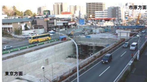
登戸交差点付近の地下立体部
