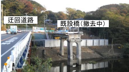
(柏井橋の施工状況 (河口から約9km))
