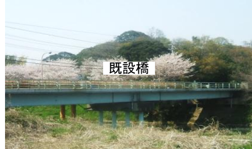
(亥鼻橋の現況 (河口から約6km))
