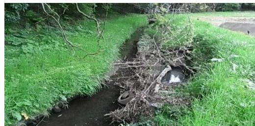
(高田排水路東部支線)
