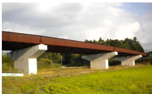
(下田大橋の桁架設完了状況)
