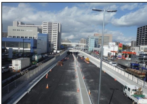
地下立体部の施工状況
