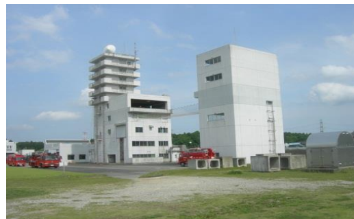
(訓練塔及び補助訓練塔)
