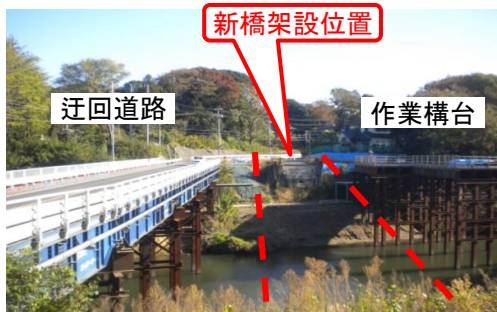
(柏井橋の施工状況 (河口から約9km))
