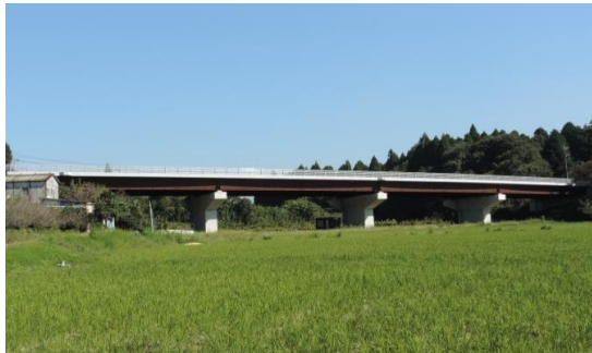
(下田大橋の床版完了状況)
