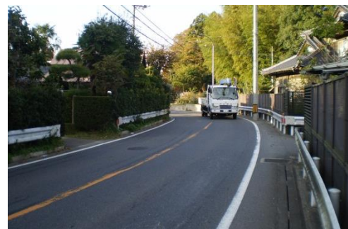
(幅員が狭く歩道もない現況道路)
