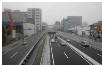
地下立体部の施工状況
