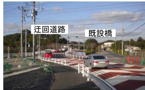
(亥鼻橋の現況 (河口から約6km))
