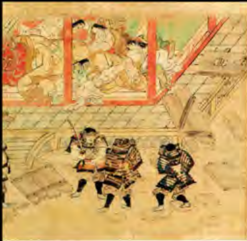
破られた直後の「鐵石の室」 (下巻・絵第6段)
