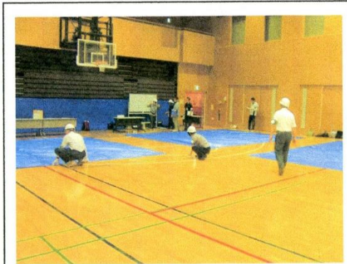
★居住区シート敷設(施設班)
