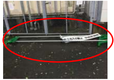
暴風雨により看板破壊
