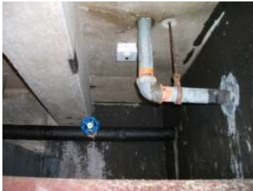
天井・壁面に結露は見られない。
