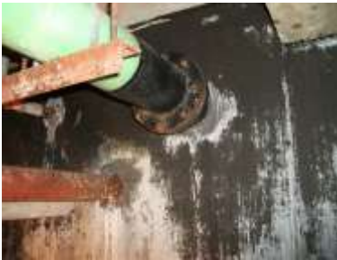
ガス本管引込口
