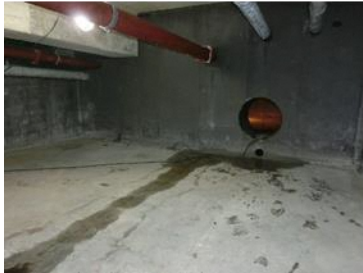
ピット1(点検口直下)
