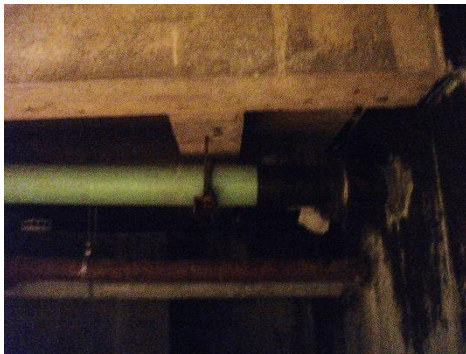
スラブ（天井）・排水管・壁面乾いていた。
